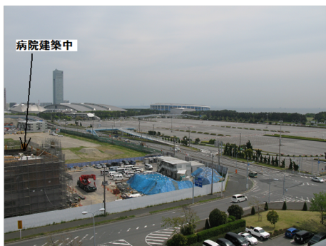
写真 1 建築中の東京ベイ先端医療・幕張クリニック
